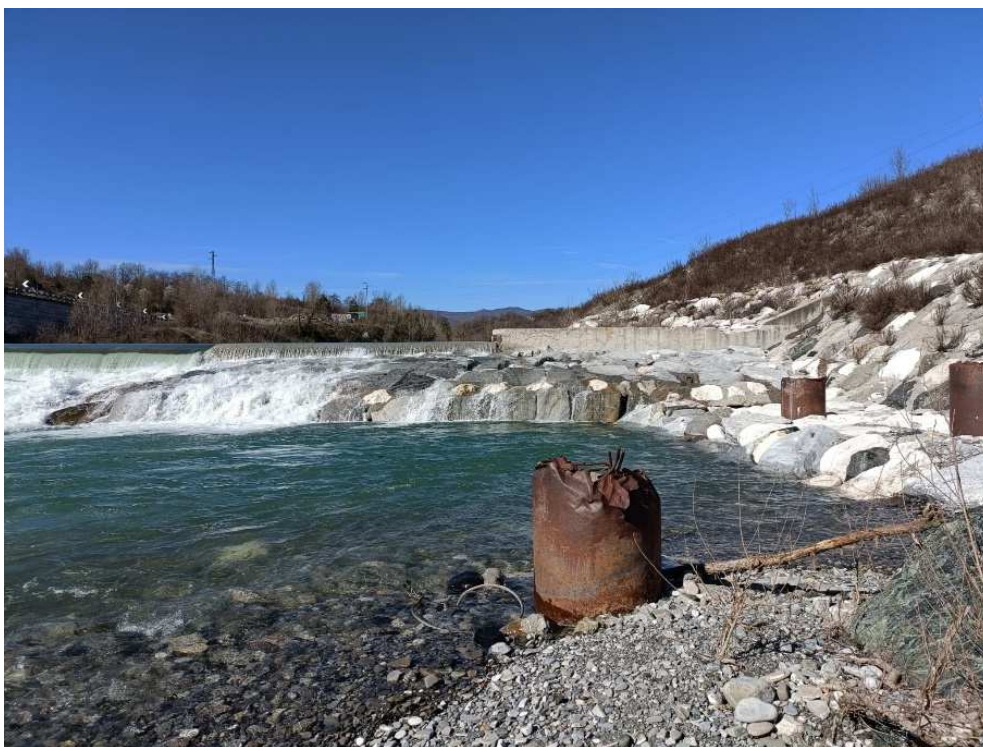
Figura 3-4. Vista della briglia da valle della stessa con individuazione di scogliera di protezione in sinistra idraulica e pile di dissipazione.
